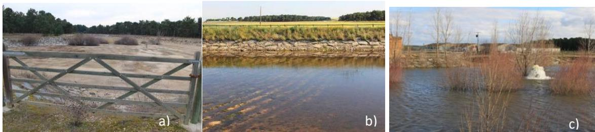
Figura 6-2-6. a) rampa de acceso para las operaciones de mantenimiento, b) fondo arado en una balsa de infiltración en Santiuste; balsa de infiltración con vegetación que podría mejorar la tasa de infiltración.
