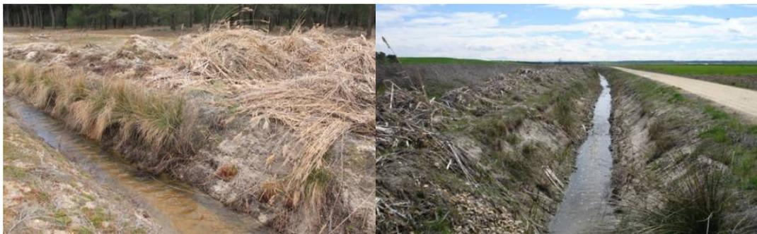
Figura 6-2-7. Operaciones de limpieza y mantenimiento en el canal occidental de la Cubeta de Santiuste en 2015.
