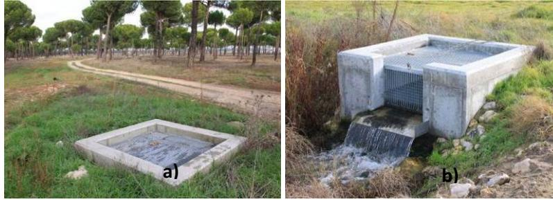
Figura 6-2-1. Ejemplos de Alcazarén: a) aliviadero para desbordamiento y b) cabecera del canal 3.
