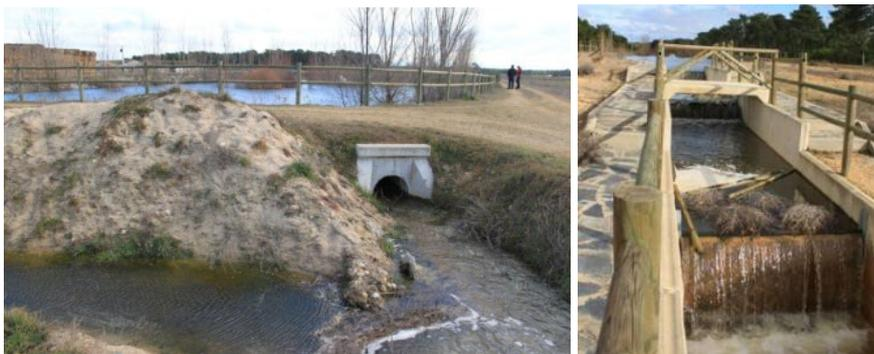
Figura 6-2-5. Estructuras de retención e infiltración en El Carracillo.
