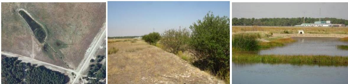
Figura 6-2-2. "Triplet" en el Carracillo compuesto por a) una balsa de infiltración, b) un biofiltro en el tramo de canal y c) una zona de tratamiento por lagunaje en un humedal artificial.
