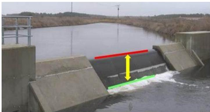
Figura 6-2-4. Presa del MAR diseñada específicamente para controlar el nivel de base del acuífero.
